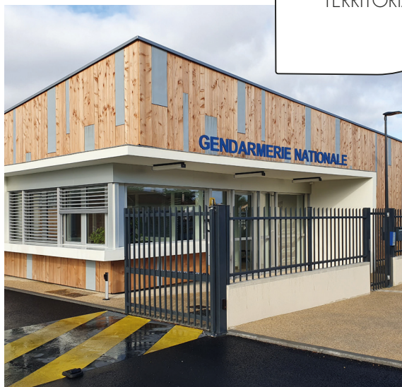
Gendarmerie de Vouillé, Architecte : agence Corset-Roche
